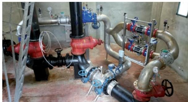
Fig.3: Gruppo di misura e di riduzione della pressione al pensile di Correggio
