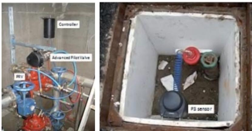
FIGURA 3: INSTALLAZIONE DI UN SISTEMA DI CONTROLLO CON ALGORITMO DI AUTOAPPRENDIMENTO
