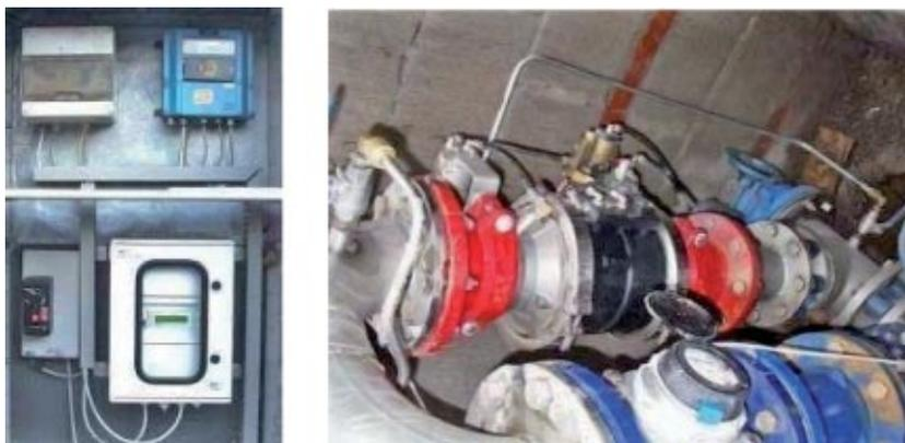
FIGURA 2: DATA LOGGERS E UN PUNTO DI MISURAZIONE
