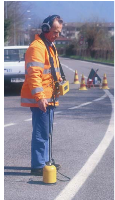
Figura 4. Ricerca perdite con Geofono
