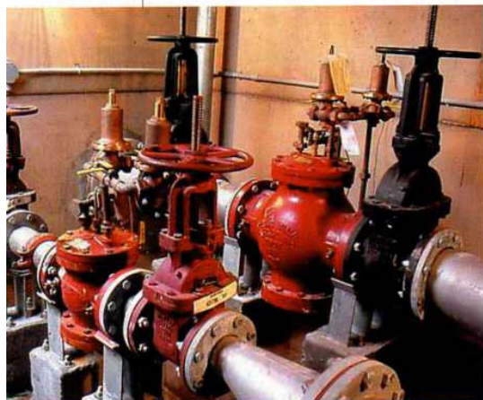
FIGURA 4 CAMERETTA CON VALVOLE PER LA GESTIONE DELLA PRESSIONE
